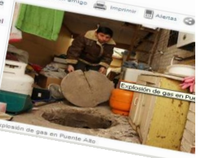
Explosión de gas en Puente Alto
