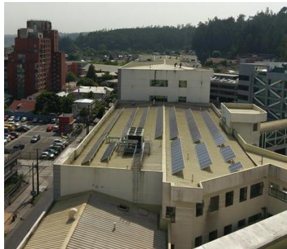
Hospital Clínico Concepción (100 kW) Inversión Aprox.: $74 millones Ahorro: $ 10 millones al año Superficie: 1000 m 2 a 3000 m 2
