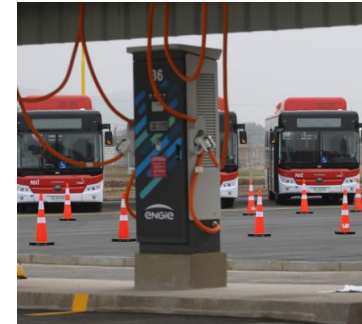
Terminal de buses VULE 37 Cargadores de 150kW Para 74 buses app. Carga en 4 horas
