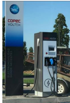
23 estaciones de carga eléctrica A lo largo de 700km Carga AC y DC de 43kW y 50kW Carga DC Ultra Rápida de 175kW
