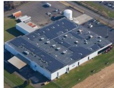
Sistema de 300 kW (ejemplo) Inversión Aprox.: $177 millones Ahorro: $ 33 millones al año Superficie: 5000 m 2 a 9000 m 2
