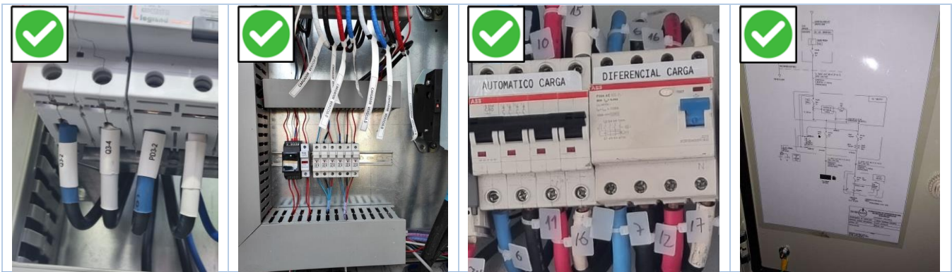
Imagen 22: Identificación de cables y diagrama unilineal en tablero.
