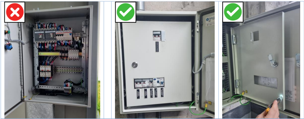
Imagen 17: Tableros sin cubierta cubre equipos (izquierda), Tablero con cubierta cubre equipos (derecha).
