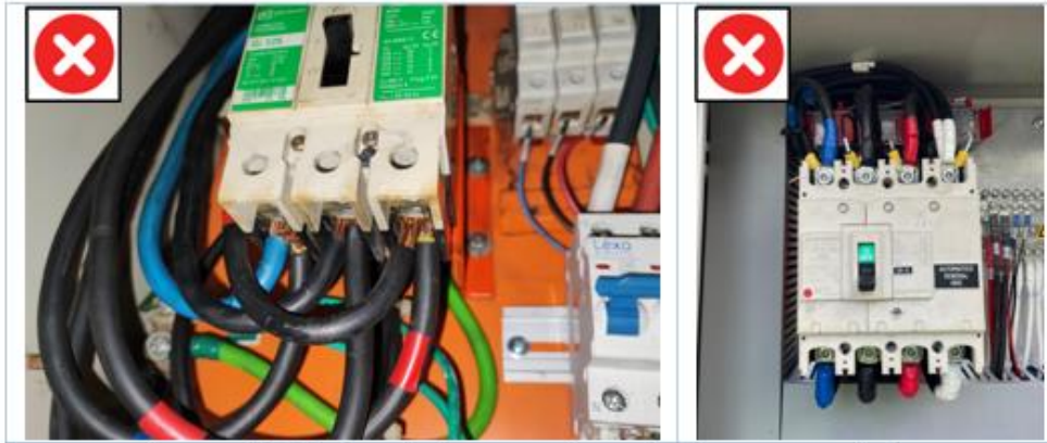
Imagen 23: Malas prácticas uso de conductores en paralelos.
