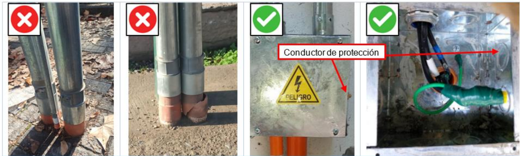
Imagen 42: Mezcla de canalizaciones de ductos metálicos con ductos no metálicos.
