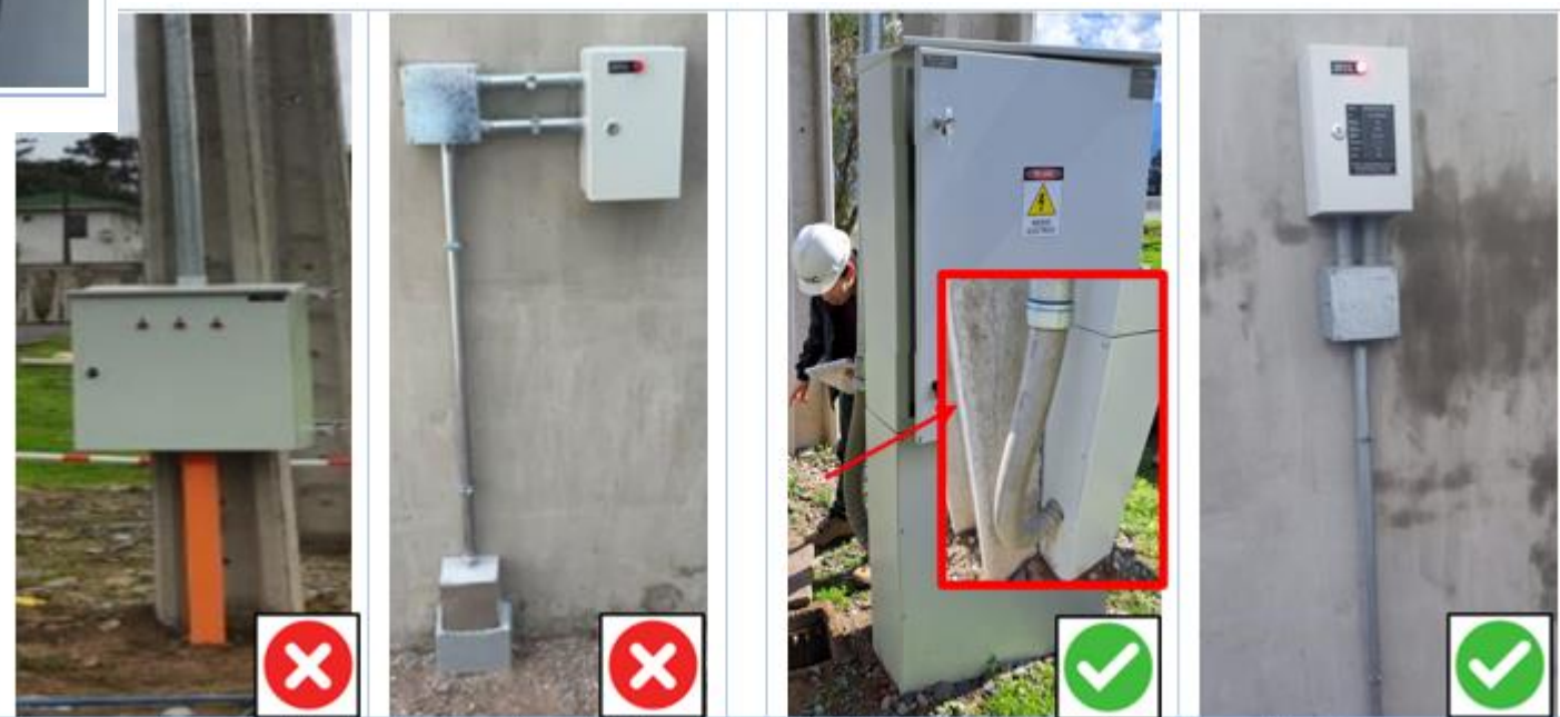
Imagen 11: Buenas y malas prácticas respecto al ingreso de canalizaciones a Tableros.
