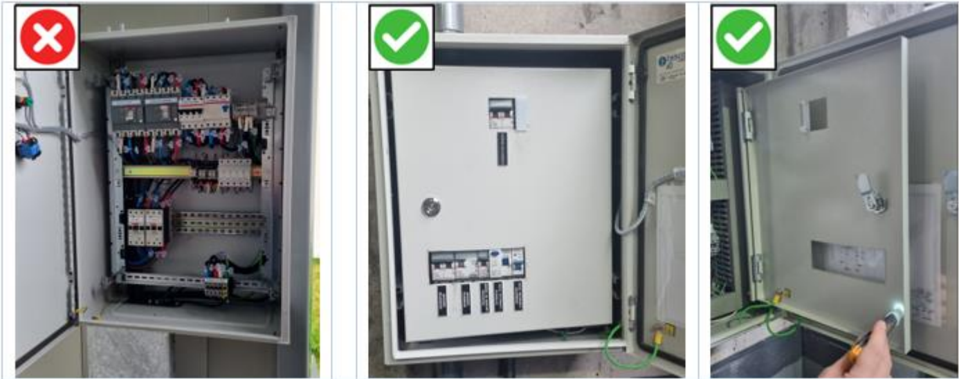
Imagen 13: Tableros sin cubierta cubre equipos (izquierda), Tablero con cubierta cubre equipos (derecha).
