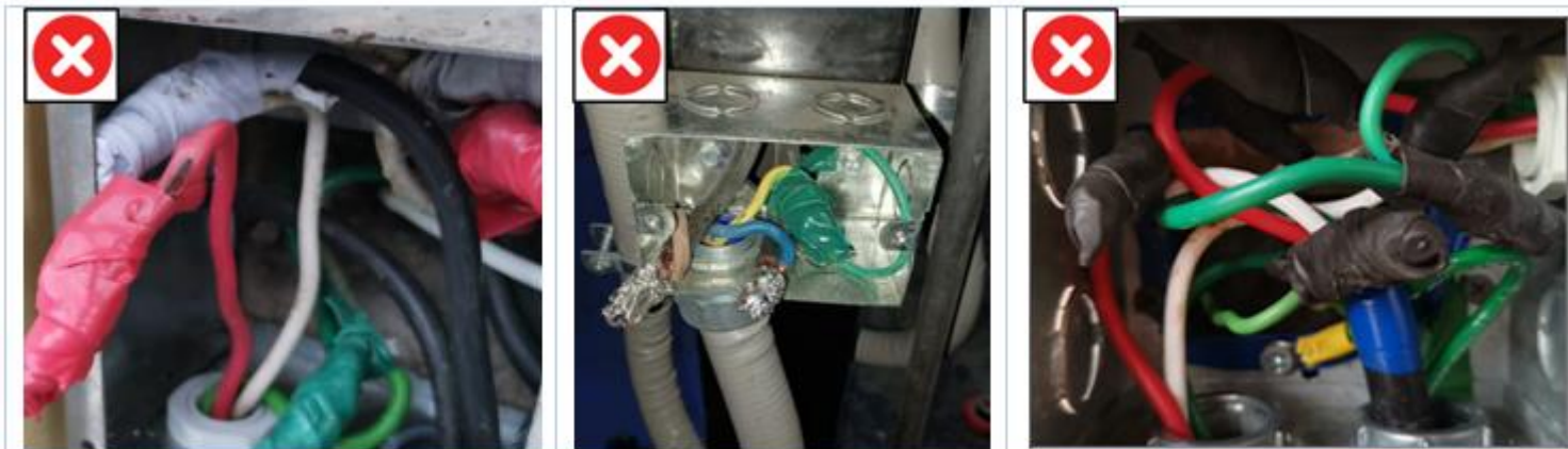
Imagen 37: Malas prácticas uniones de conductores.
