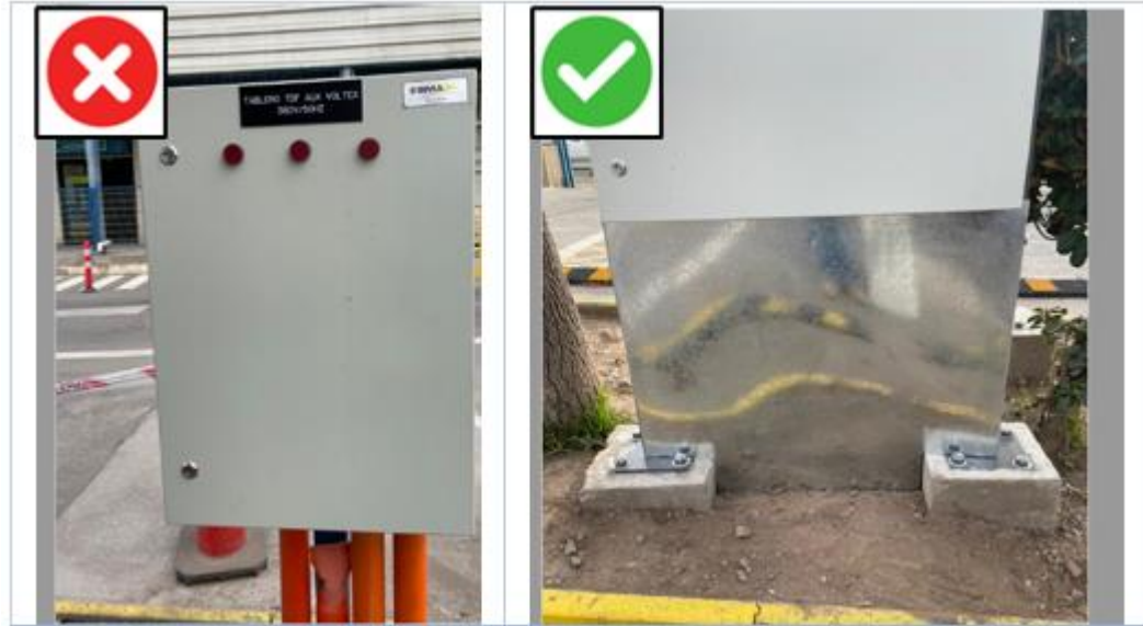
Imagen 40: Exposición de tuberías no metálicas a radiación solar.
