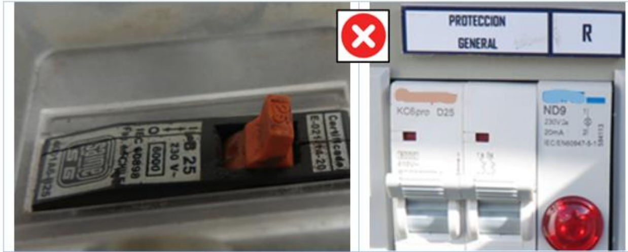
Imagen 30: Coordinación y selectividad de protecciones.
