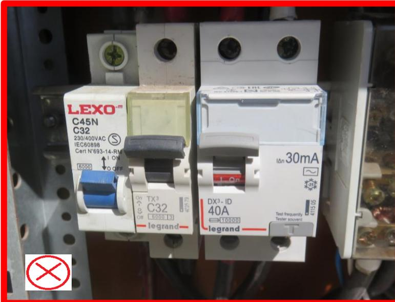
1. No se instala protección termomagnética bipolar (RGR 02/2020, numeral 14,12).
