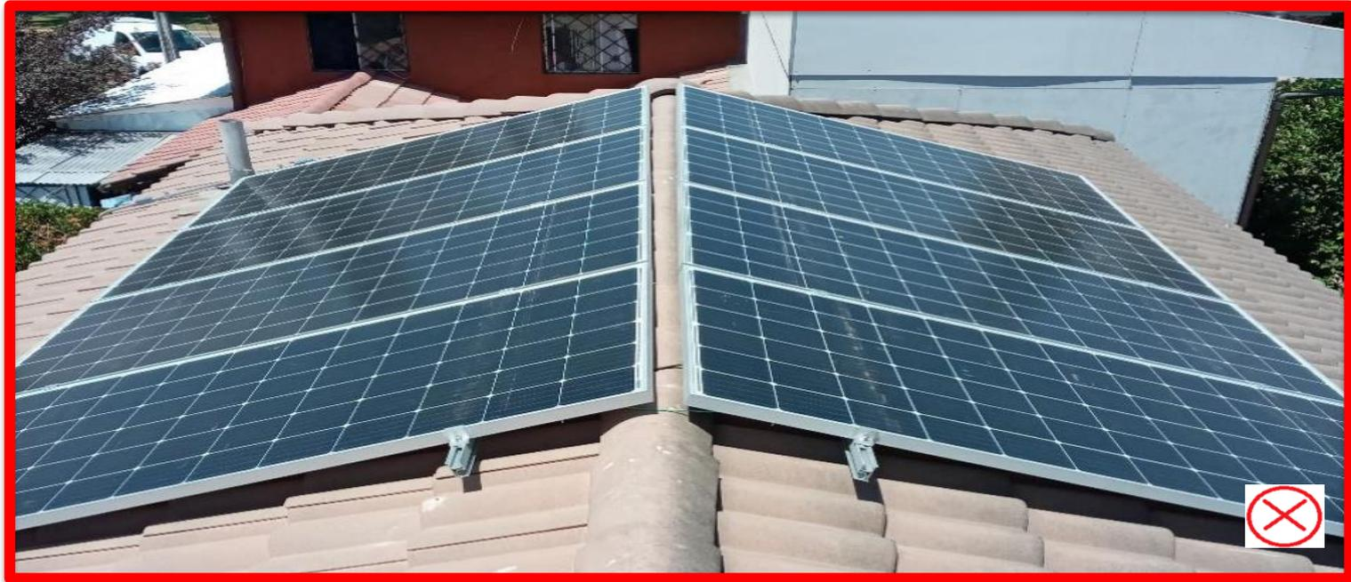
No se podrán utilizar módulos fotovoltaicos de distintos modelos,
