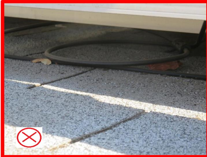
3. Los cables de CC no deben estar sometidos a esfuerzos mecánicos y no deben tocar la parte trasera del módulo fotovoltaico ni el techo; deben estar amarrados y ordenados (numeral del RGR 02/2020 puntos 11.9 y 11.10 )
