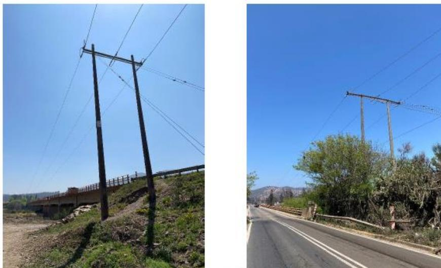
Fig. 11. Estructuras tipo portal existentes asociadas al refuerzo Cruce de Río Aconcagua
